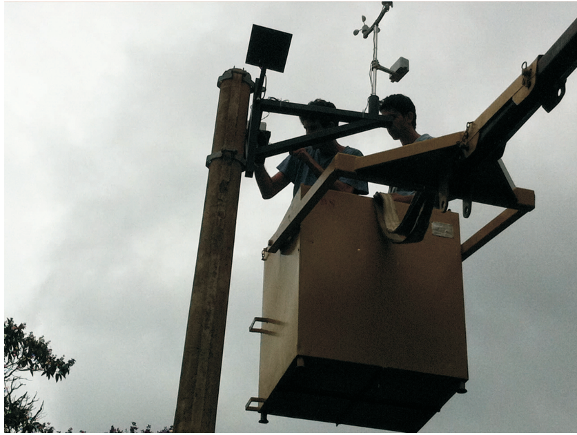
Figura 4.10: Instalação dos sensores
